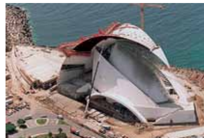
2008 AUDITORIUM DI SANTA CRUZ DE TENERIFE, SPAGNA PROGETTO ARCHITETTO SANTIAGO CALATRAVA.).
