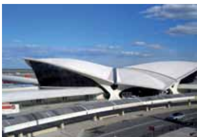
1962 AEROPORTO JFK DI NEW YORK, TERMINAL TWA. PROGETTO ARCH. EERO SAARINEN AND ASSOCIATE.
